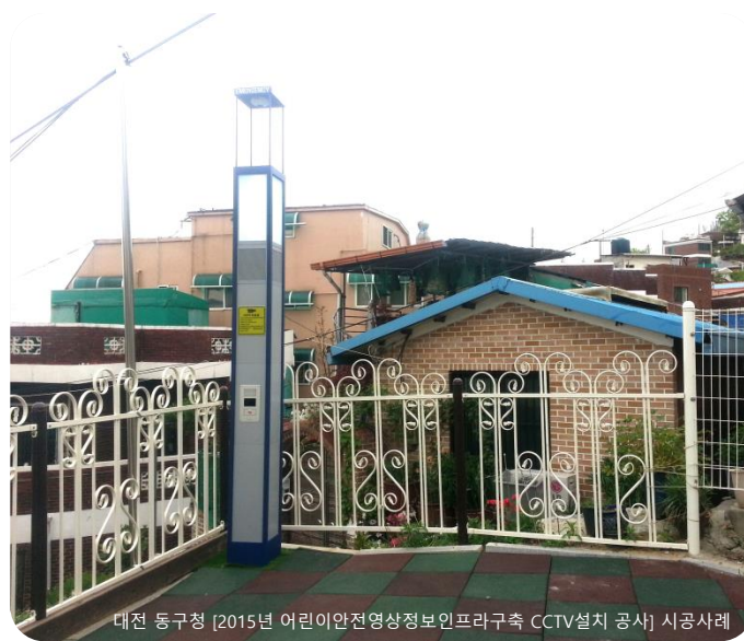
대전 동구청 [2015년 어린이안전영상정보인프라구축 CCTV설치 공사] 시공사례
